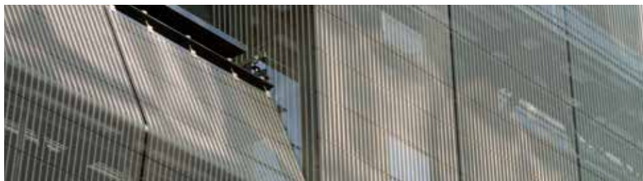
Mehrdimensionale Fassade mit 19° umgelenkten Gewebefasern. Júlia Center, Andorra la Vella, Andorra.
