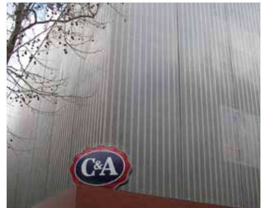
Ein semi-transparentes Edelmetallgewebe verhüllt den Bestand und sorgt für natürliche Belichtung. C&A Eco Store, Mainz, Deutschland.
