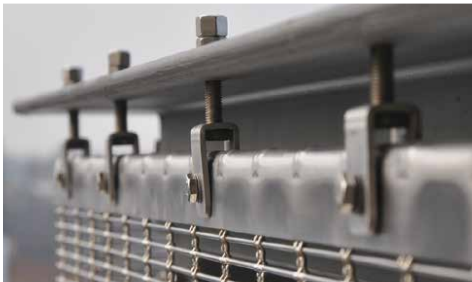
Obere Befestigung: Spannkante und Gabelschraube.
