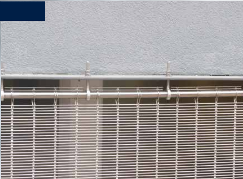
Obere Befestigung: Rundstab mit Augenschrauben.
