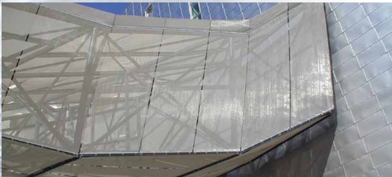
Dreidimensionales Vordach mit individuell gespannten Elementen: Messe Malaga, Spanien.
