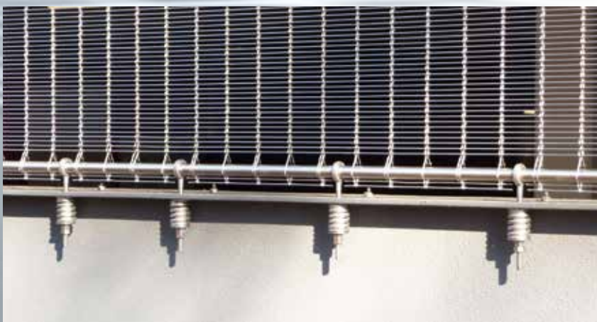
Untere Befestigung: Rundstange mit Augenschrauben und Druckfeder.
