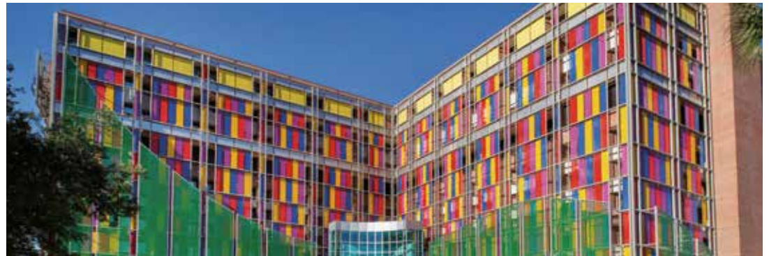
Kleine Drahtgewebe-Elemente verkleiden den alten Klinkerbau. Shands Children's Hospital, Florida, USA.
