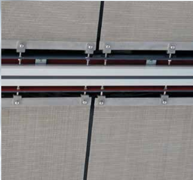
Nicht-revisionierbares Befestigungssystem für Decken mit Spannkante und Gabelschraube.
