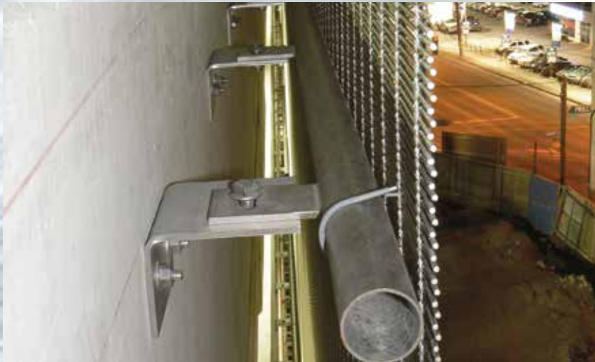
Zwischenbefestigung: Rundrohr und Drahtsicherung.
