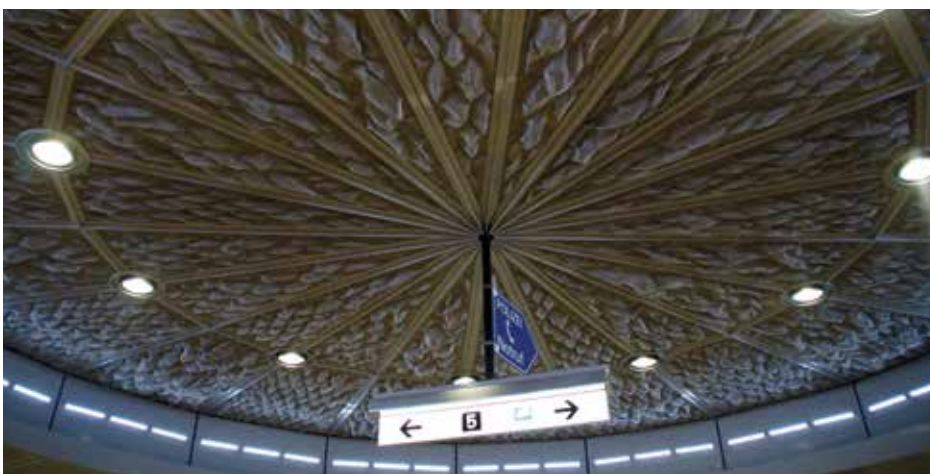
Dreidimensional verformtes Edelmetallgewebe zur Verbesserung der Raumakustik. Stadtbahn Köln, Deutschland.
