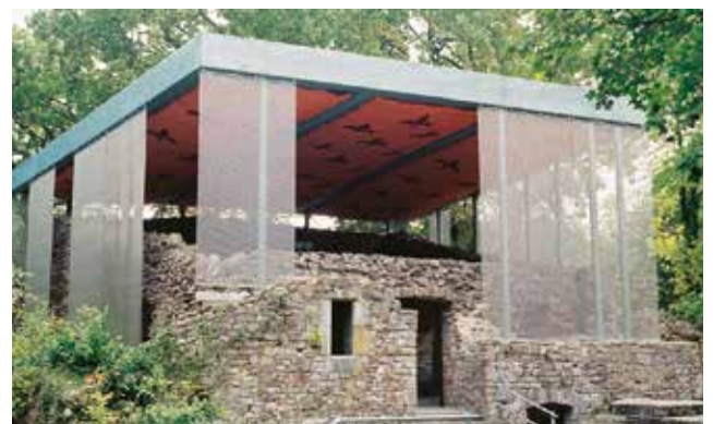
Ein semi-transparentes Edelmetallgewebe verhüllt den Bestand und sorgt für natürliche Belichtung. C&A Eco Store, Mainz, Deutschland.
