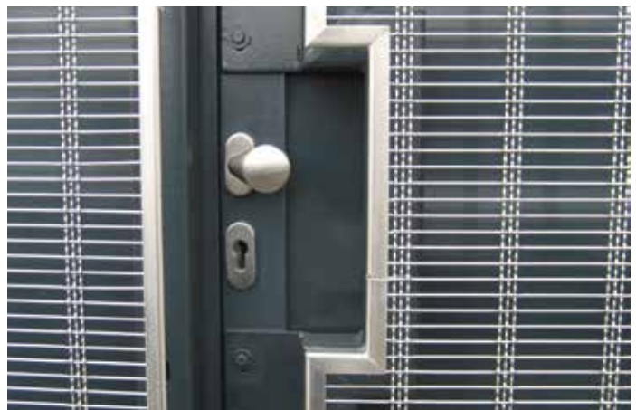
Gewebe-Einfassung mit Kantenschutzprofilen.
