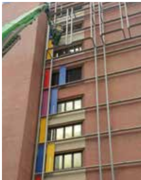
Kleine Drahtgewebe-Elemente verkleiden den alten Klinkerbau. Shands Children's Hospital, Florida, USA.
