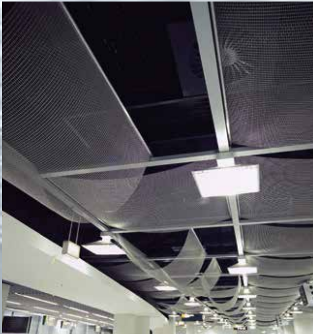
Revisionierbares Befestigungssystem für Decken mit Durchhang.
