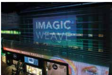
18 verschiedene Auflösungsbereiche in einer Fassade. Júlia Center, Andorra la Vella, Andorra.
