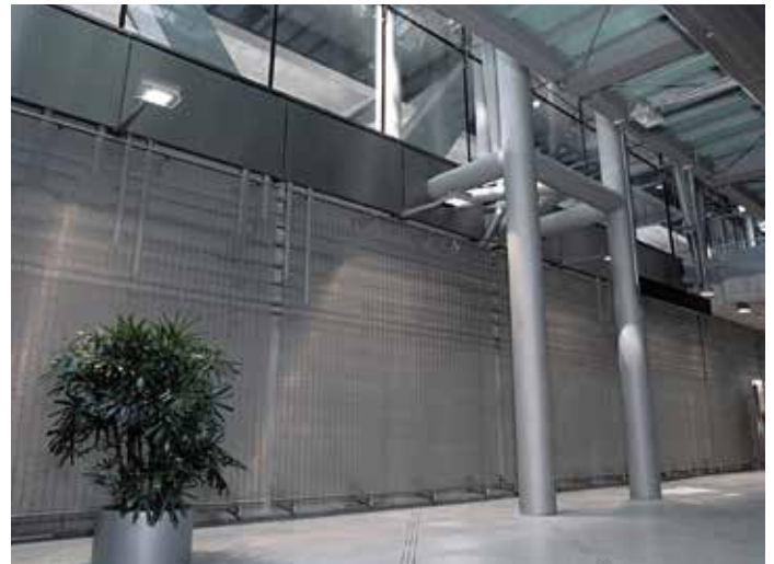
Verkleidung technischer Anlagen. Terminal 2, Flughafen Köln-Bonn, Deutschland.
