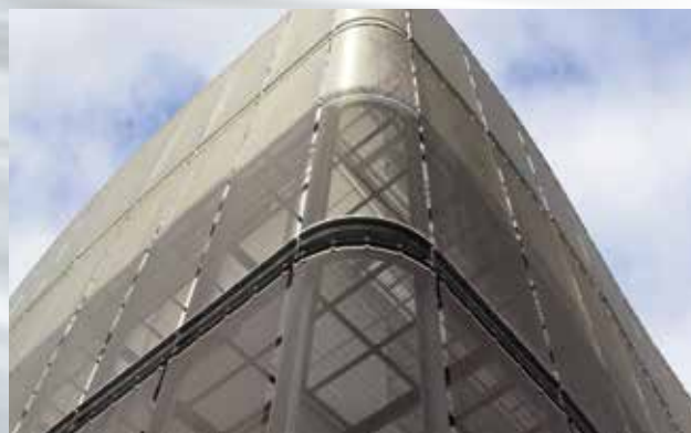
Eckbereich mit vorgerundeten Elementen: Holland Park School, London, Großbritannien.
