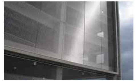
Edelstahlgewebe erlauben dank der Transparenz eine gute Luftzirkulation.
