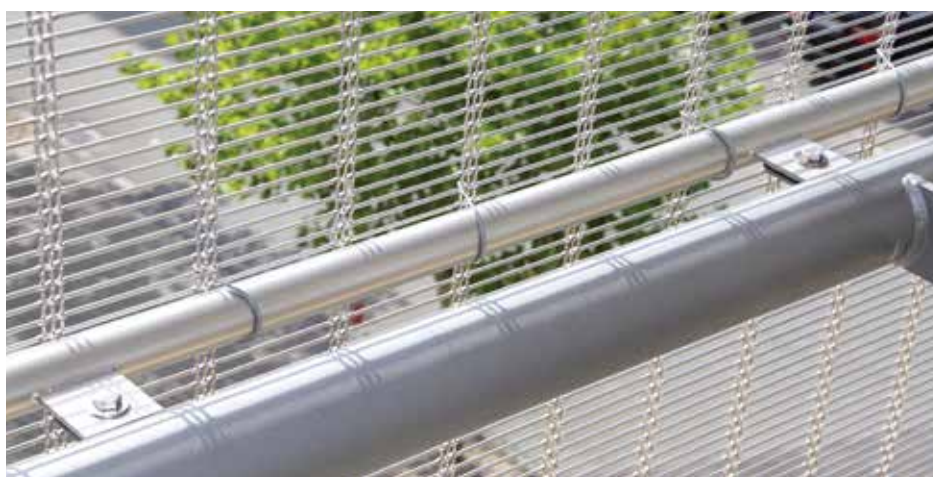
Zwischenbefestigung: Rundrohr und Drahtsicherung.
