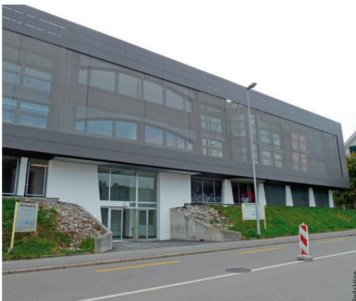
Ansicht der Nordfassade von der Seestrasse. Eternitplatten Typ Swisspearl Nobilis N012 bilden den Rahmen.
