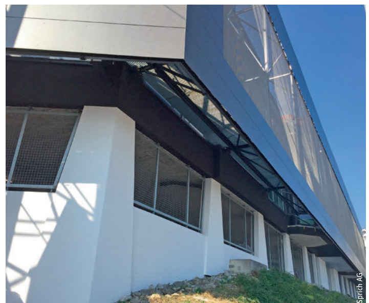
Sicht von unten. Zu erkennen ist auch der Laufsteg hinter der Fassadenhaut. Vue de dessous. On reconnaît la passerelle derrière l'enveloppe de la façade.
